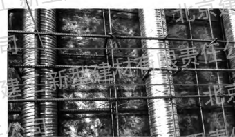
图2 波纹管限位钢筋
