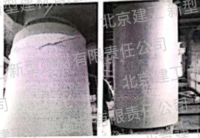
图 5-1 清水混凝土养护
